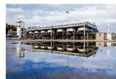
Eine technische Anlage zur Kühlung von Erdgas in Rehden. FOTO: DPA
