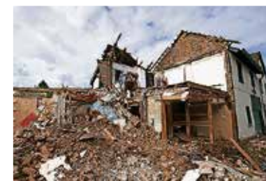
Hochwasserschäden in Gemünd in der Eifel Ende Juni. FOTO: DPA
